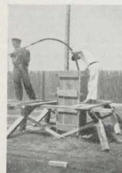
Fig. 4. Vervaardiging van een kolom met inwendige vibratie.
