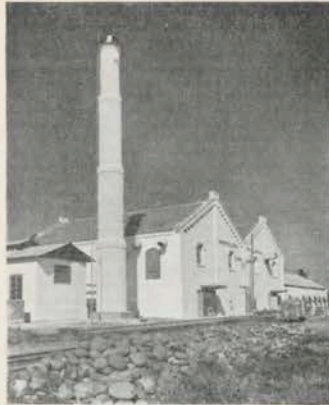
Fig. 9. Schoorsteen ener rijstpellerij, opgebouwd uit eenheden van schokbeton.
